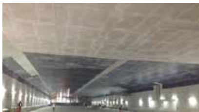
SINGAPUR SINGAPUR TÚNEL MARINA COASTAL E.XP. 482
