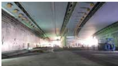
EMIRATOS ÁRABES ABU DHABI TÚNEL AL SALAM
