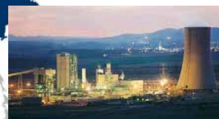
ESPAÑA PUERTOLLANO REFINERÍA REPSOL
