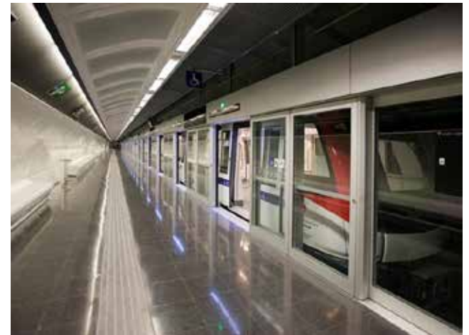
Línea 9 del metro de Barcelona, España
