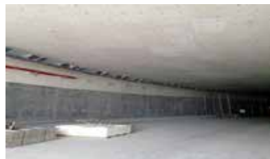
E.A.U. ABU DHABI TÚNEL BAYNOONAH ST.
