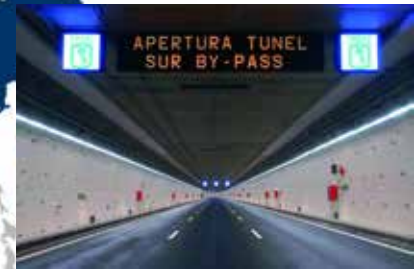
ESPAÑA MADRID TÚNEL CIRCUNVALACIÓN M30
